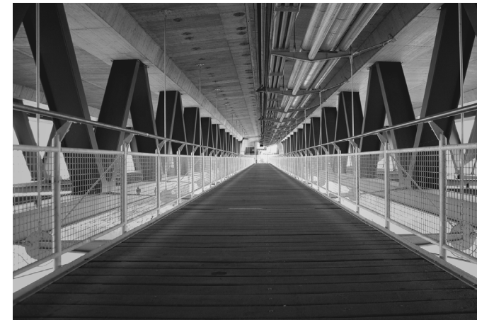
Fußgängersteg unterhalb der Salzburger Autobahnbrücke. Linien führen zur Mitte des Fotos.
